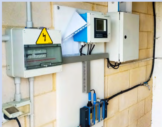
Dispositivos de control de los depósitos del agua.
